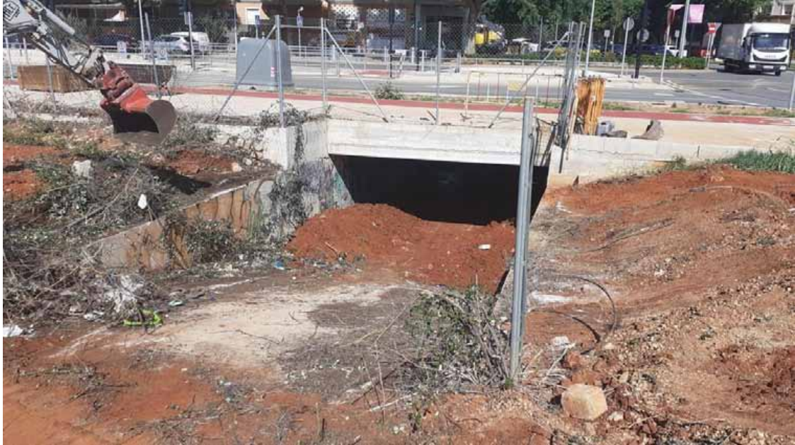
Dénia pone a punto los colectores de aguas pluviales ante la llegada de las lluvias. / Levante-EMV
