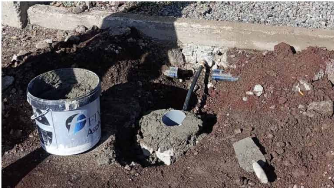
Mejoras en la red de saneamiento de Teguste. / E. D.
