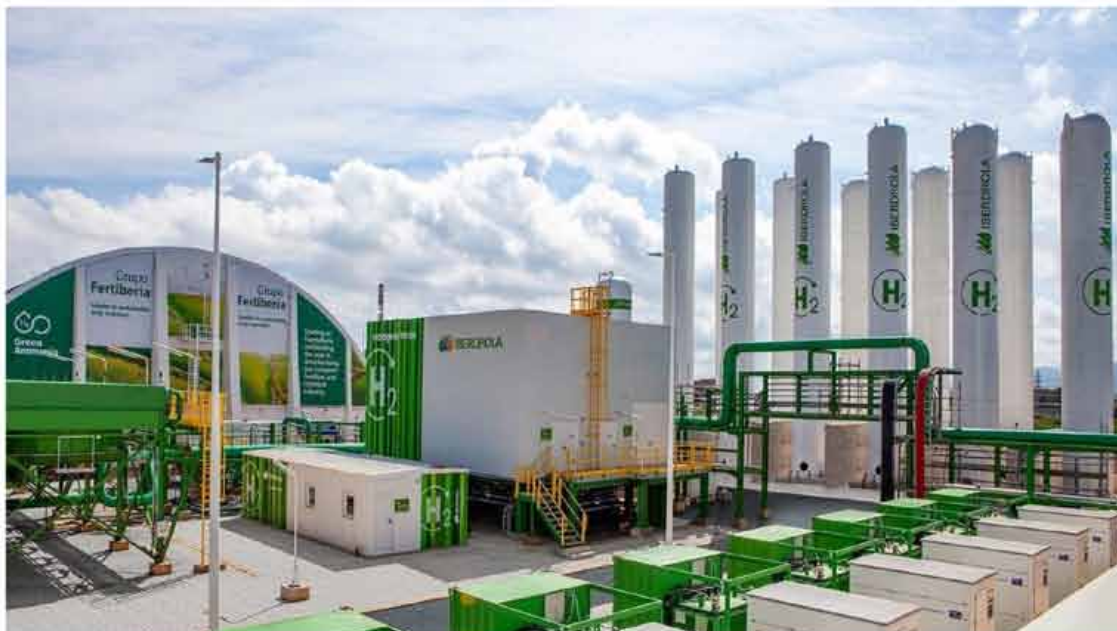
Planta de hidrógeno verde de Puertollano / Iberdrola
