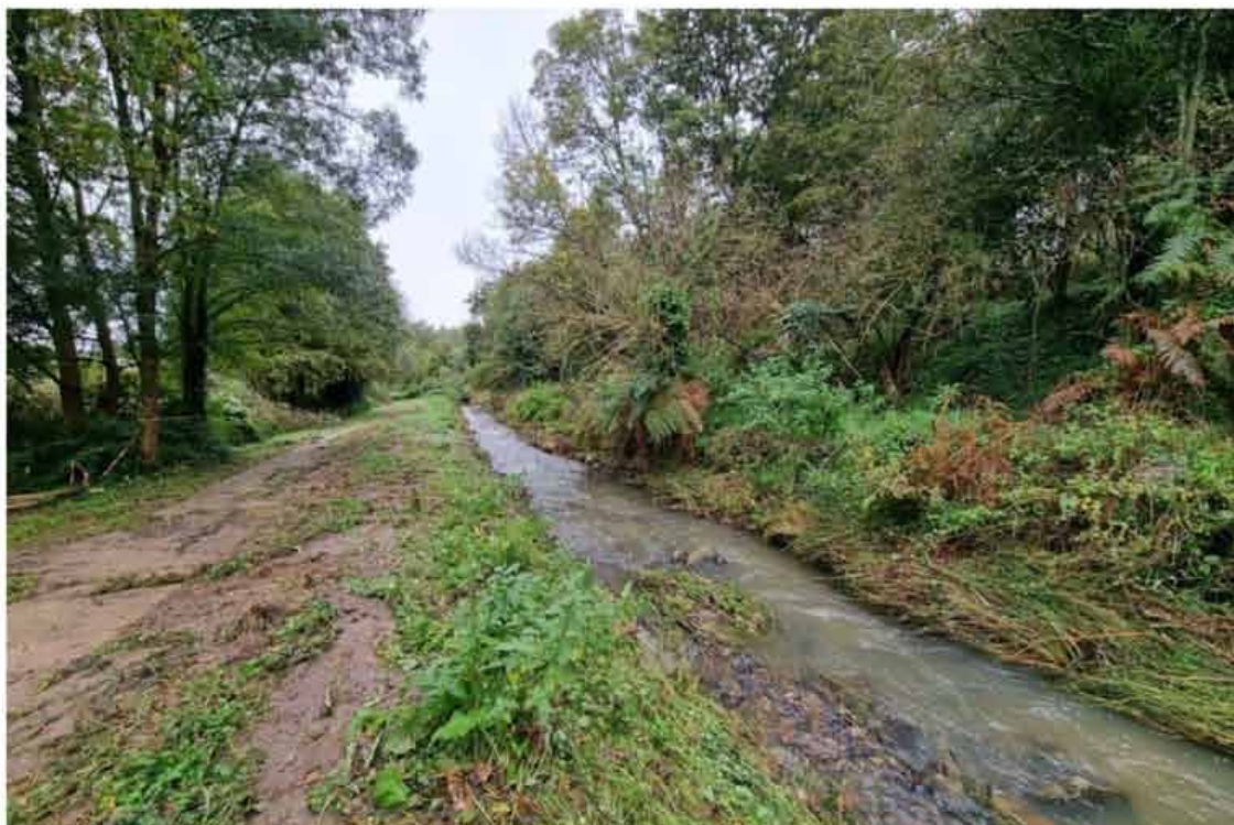
Exemple de travaux qui va être fait. A Divatte-sur-Loire, le lit du ruisseau de la Boisardière, très rectiligne, va être aménagé pour lui redonner un aspect plus naturel, en forme de méandres. ©HSM
